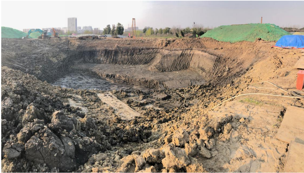
图4-3 施工期场地抑尘措施
