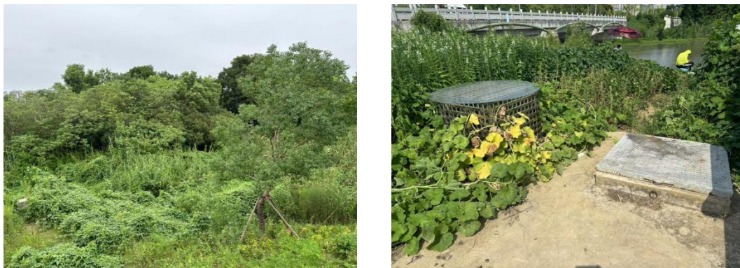
图4-5 护坡、绿化等水土流失保护措施运行现状
