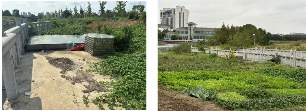
图4-6 闸站及降噪措施运行现状
